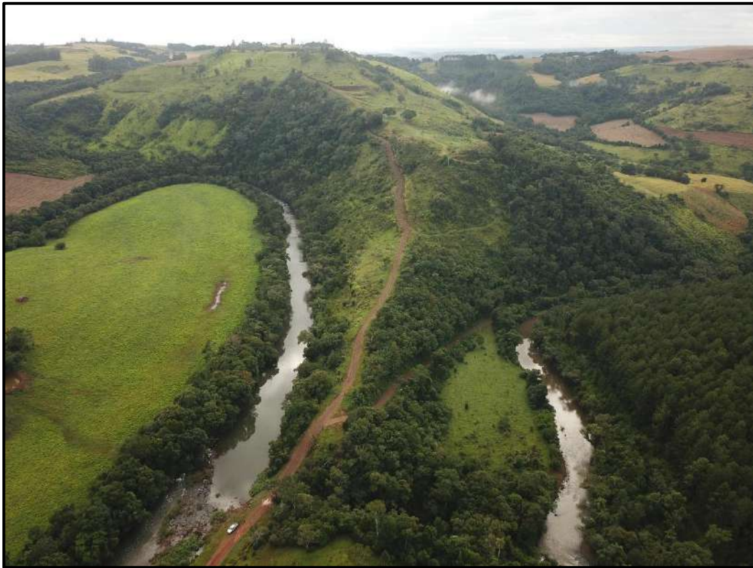
Figura 12. Área de implantação da casa de força ( braço esquerdo ) e da barragem ( braço direito ).
